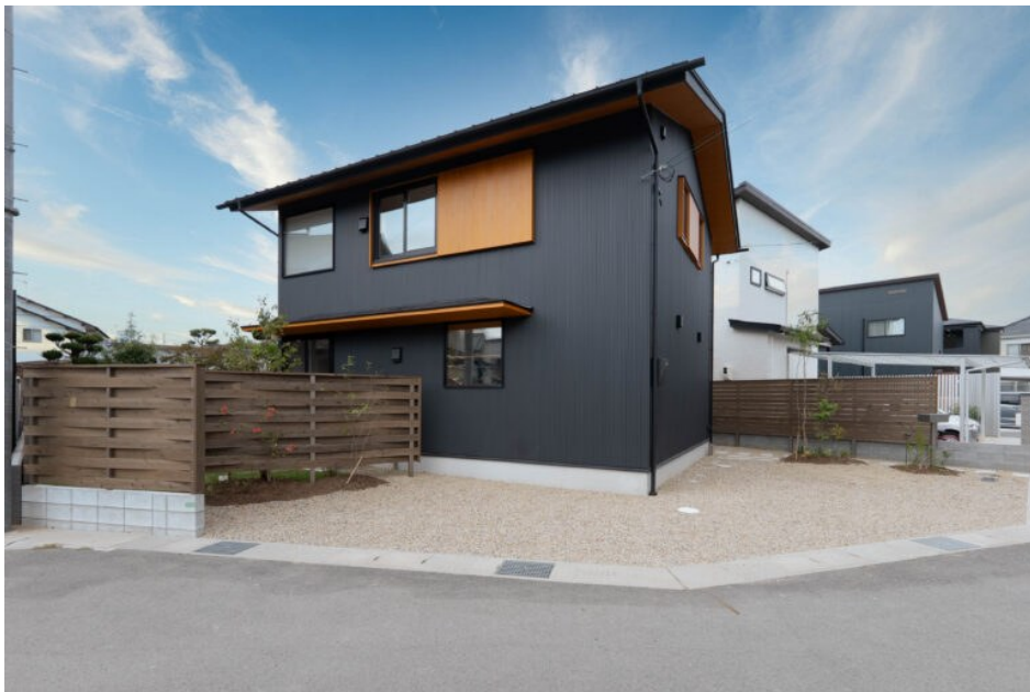
オリジナルガルバリウム外壁 | コーキングが少ない 施工事例：ふたつ庭の家
