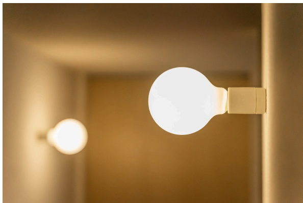
廊下に2灯。碍子と丸電球だけの、いちばん簡単な灯り。
